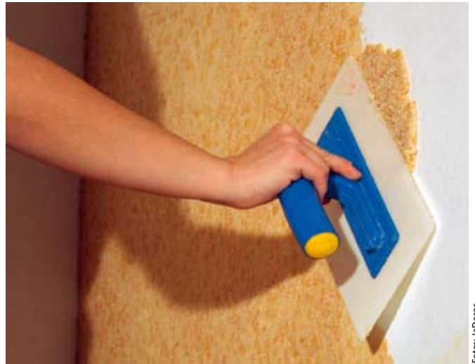
Eine Viertelstunde später wird der »Baumwollmörtel« in einem Arbeitsgang mit einer dünnen, elastischen Kunststoff-Glättkelle aufgebracht.
