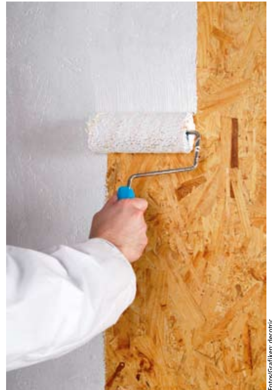
Ausblutende Inhaltsstoffe aus OSB-Platten lassen sich mit Aqua-Deck Isolierweiß dauerhaft unschädlich machen.
