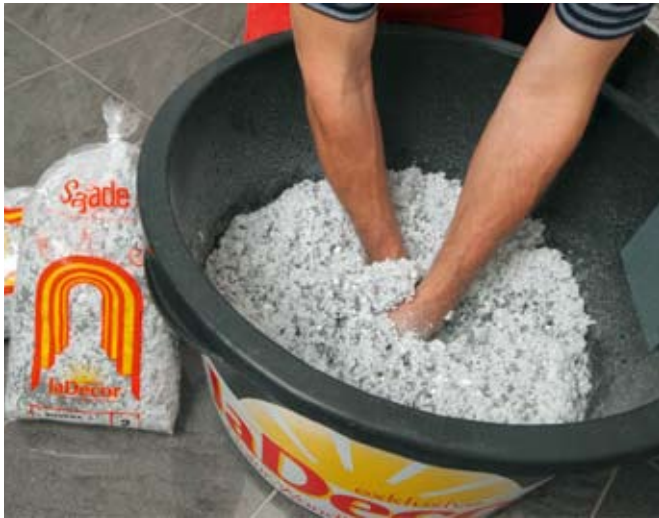
Die fertige Trockenfasermischung wird einfach in einem Bottich oder Kübel von Hand mit der auf dem Gebinde angegebenen Wassermenge untergehoben.
