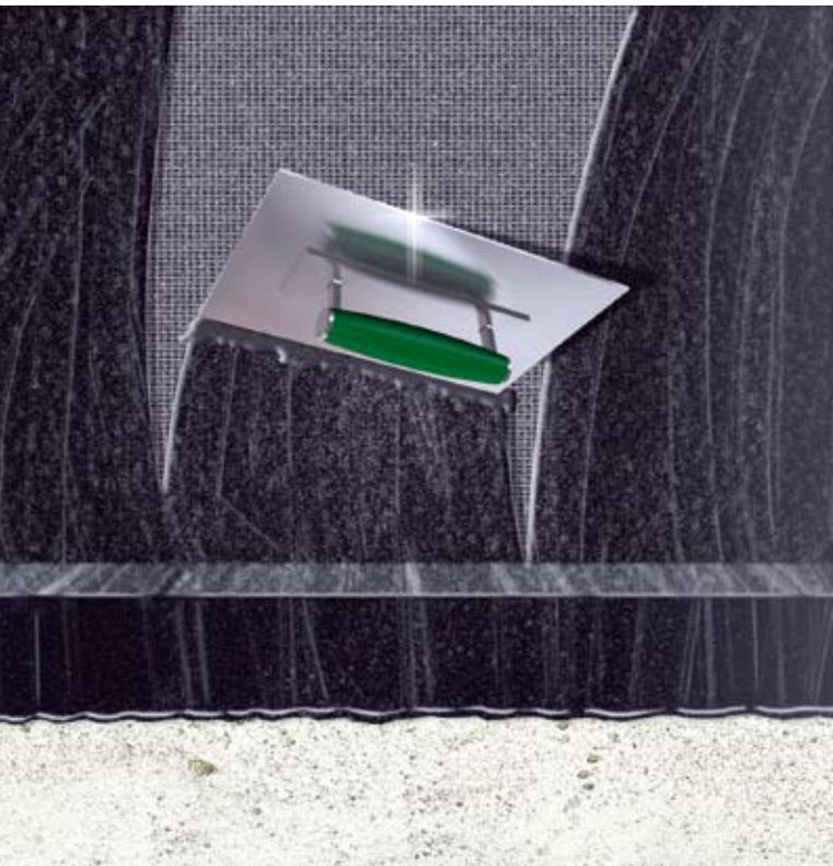
Verarbeitung der Bitumen-Dickbeschichtung: Je nach Lastfall soll mit einem Armierungsgewebe verstärkt werden.
