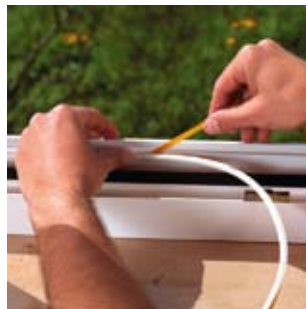
Besonders hochwertige Klebstoffe sorgen dafür, dass die Profildichtungen aus Gummi bis zu acht Jahre halten.
