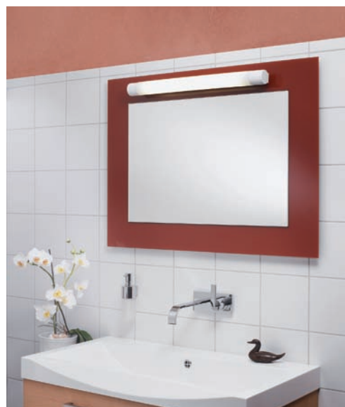
Grundbeleuchtung mit Leuchtstofflampe.
