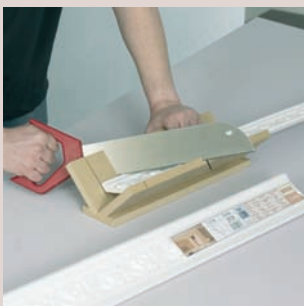
1. Zierprofile mit der Gehrgungslade zuschneiden.
