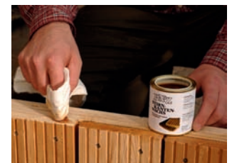
Eine Spezialanwendung: Versiegeln der Schnittflächen einer Verschalung mit Stirnkantenwachs
