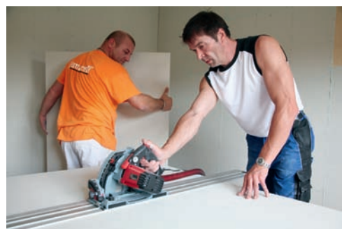
Die beschichteten Platten können wie herkömmliche Produkte durch Ritzen, Brechen, Sägen, Fräsen oder Bohren bearbeitet werden.
