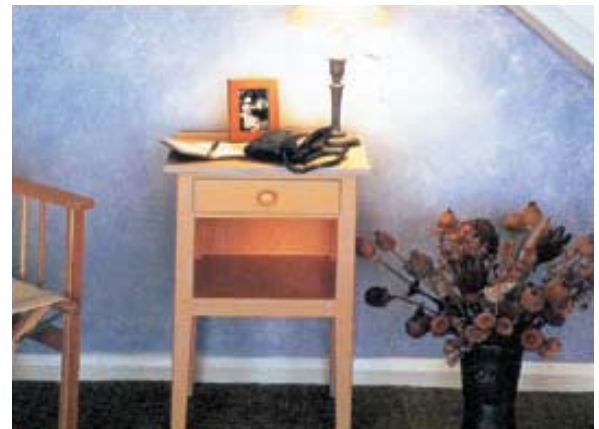
Stimmungsvoller Farbeinsatz und eine gewollte Unregelmäßigkeit in der Farbfläche machen den Reiz dieser Techniken aus. Das Foto zeigt eine mit Effektfarbe und Wickeltechnik hergestellte Wandgestaltung.
