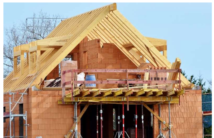
Später nicht sichtbare Ziegel werden Hintermauerziegel genannt.
