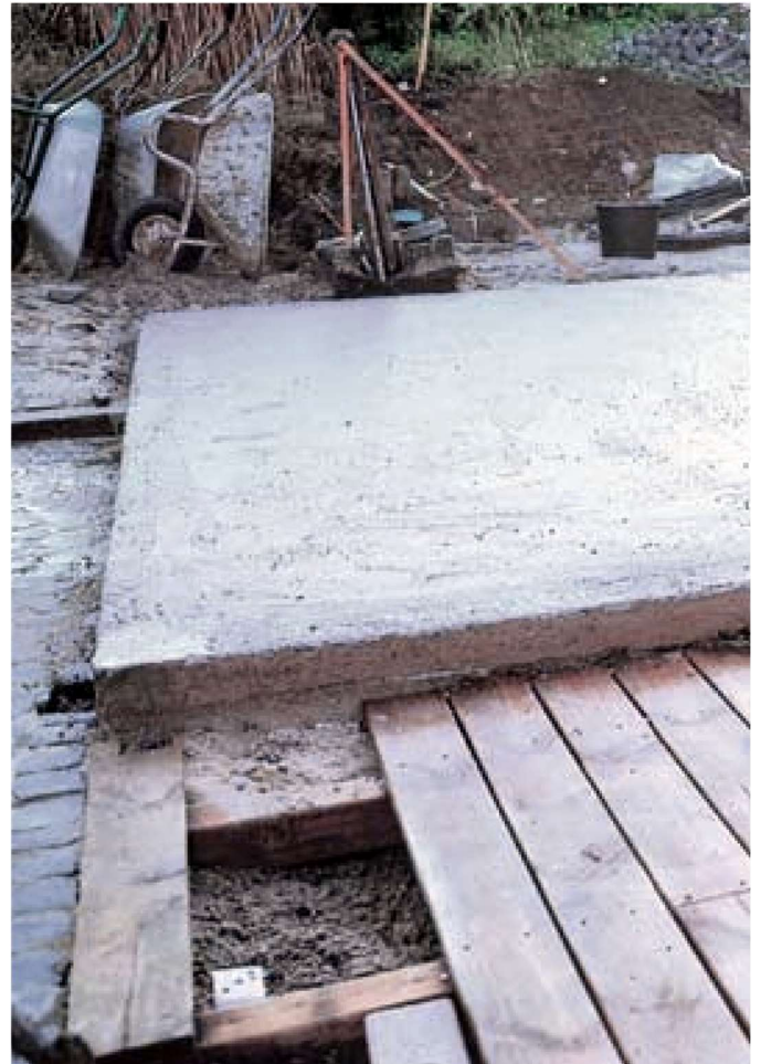
Bei Verlegungen im Außenbereich darauf achten, dass der Zement für niedrige Temperaturen geeignet ist.
